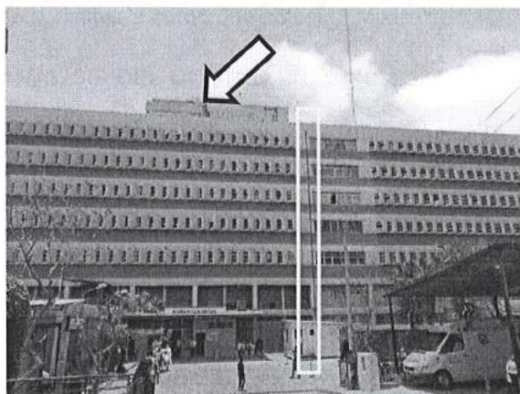
Figura 1: Se observa la junta de dilatación de 5cm insuficiente entre ambos edificios. Se señala el tanque elevado el cual recomiendan demoler.
